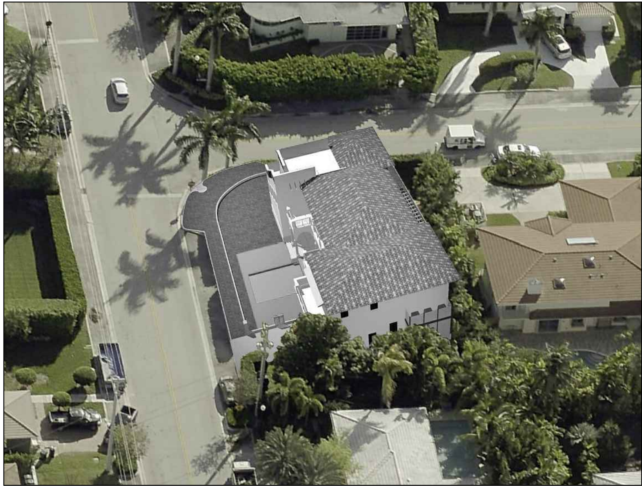
A2 North (Rear) Aerial View SCALE: N.T.S.
